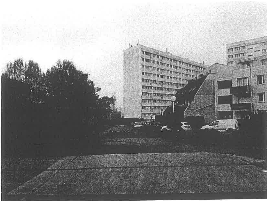
Vues de la rue du Clos Lapaume et de son débouché sur l'avenue Albert Petit
