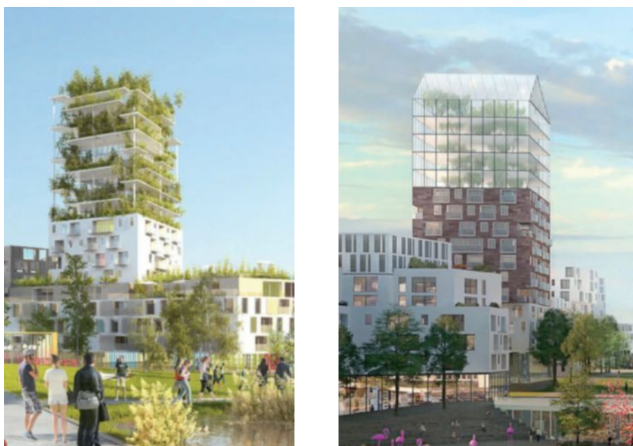
Illustration 8: Deux des trois immeubles "totems" (à gauche, l'île verte) - source : annexe 13, cahiers de prescriptions
