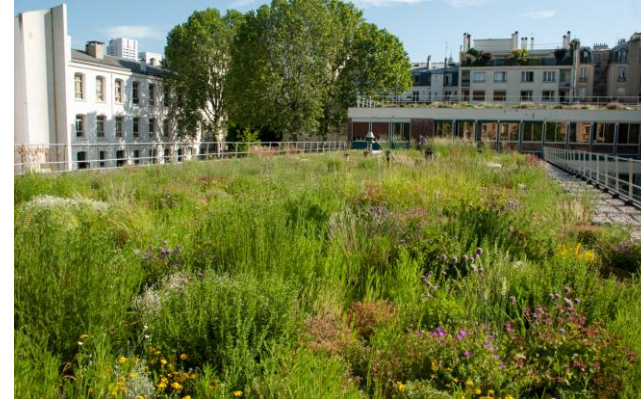
Toit végétalisé Paris
