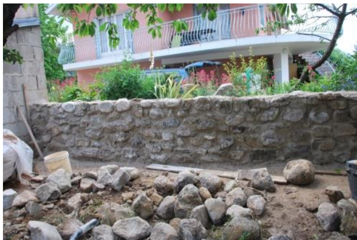
FORMATERRE - CHANTIER MESSIMY
