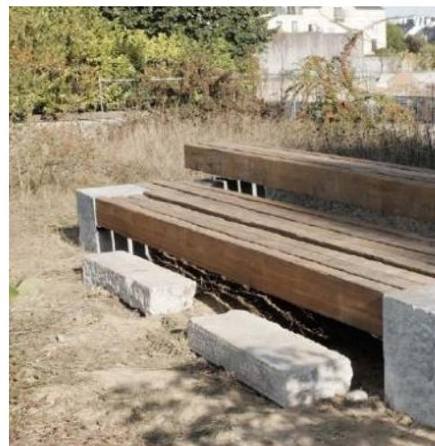
CASERNE MELLINET, ATELIER GEORGES, BELLASTOCK ASSISES À PARTIR D'ÉLÉMENTS DE CHARPENTE
