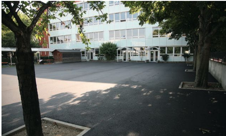
L'enrobé de la cour de l'école maternelle Henri-Wallon a été totalement refait.
