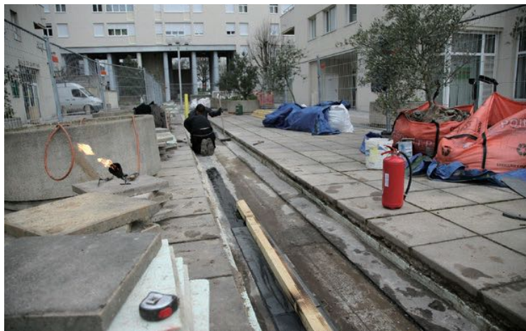
Des travaux d'étanchéité ont commencé le 3 février sur la dalle des Bas Longchamps.
