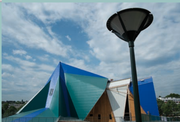
Inauguration du nouveau chapiteau P 12
