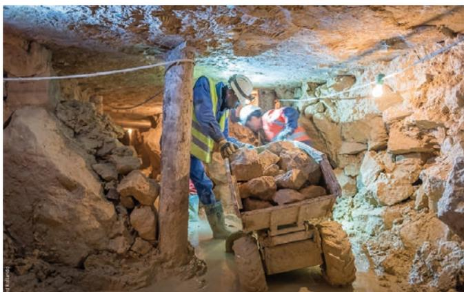
Dans ces galeries d'1,40 mètre de hauteur, les blocs de pierre trouvés sur place sont chargés sur des brouettes à assistance électrique, avant la construction de piliers en béton qui consolideront la galerie.
