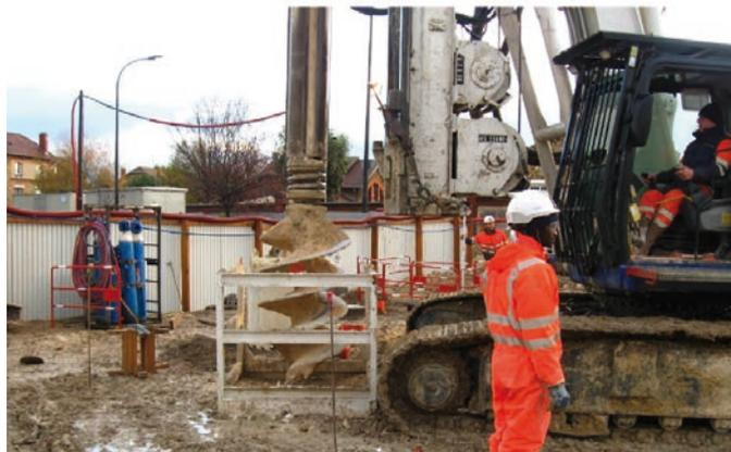
En surface, une foreuse perce des trous à 25 mètres de profondeur pour la mise en place de parois protectrices, nécessaires à la réalisation de l'accès secondaire de la future station Verdun sud, à la limite de Montrouge.
