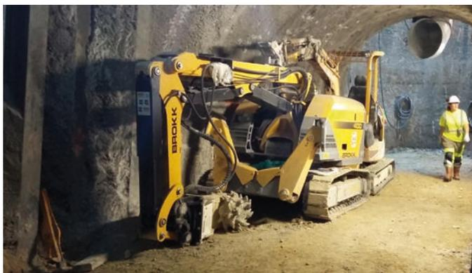
Cette machine ronge la pierre avec ses têtes abrasives pour creuser un tunnel. Attention : il s'agit d'une galerie destinée à faciliter l'accès des machines pour le confortement du terrain et des carrières, pas encore du tunnel du métro, dont le percement ne démarrera que dans plusieurs mois.
