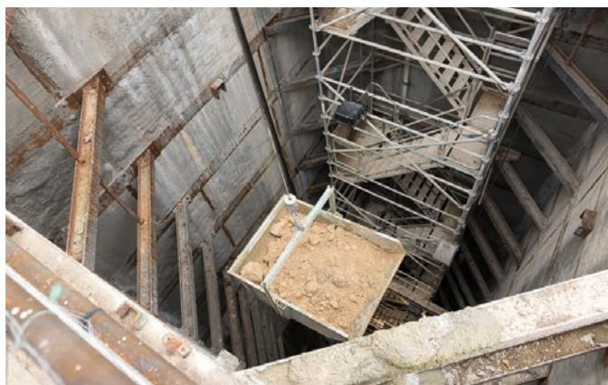
L'une des "portes d'entrées" du chantier souterrain est un puits de 30 mètres de profondeur, dans lequel les ouvriers descendent en empruntant une dizaine d'échelles. Une grue remonte les déblais, qui sont évacués par camions.
