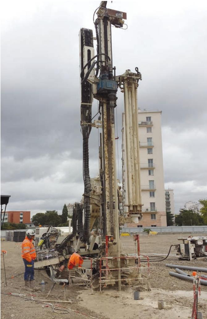
À cet endroit, le métro ne sera qu'à 7 mètres sous terre. Cette machine sert à conforter le terrain en injectant du béton directement dans les carrières au moyen de tubes d'acier, vissés les uns sur les autres.
