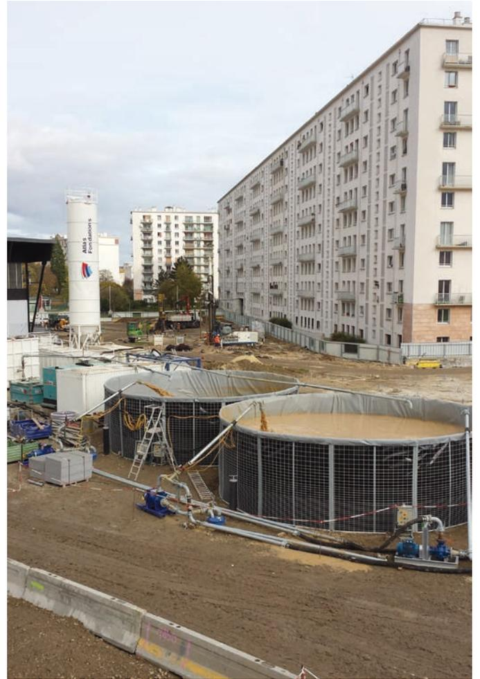
Les murs de la future station Bagneux sont réalisés suivant la technique des parois moulées. Lors du creusement, une boue à base d'argile (bentonite) est utilisée pour maintenir en place le terrain avant l'injection du béton. Lorsque le béton est coulé, la bentonite remonte, puis est réutilisée plus loin sur le chantier. Entre deux utilisations, elle est stockée dans ces réservoirs.
