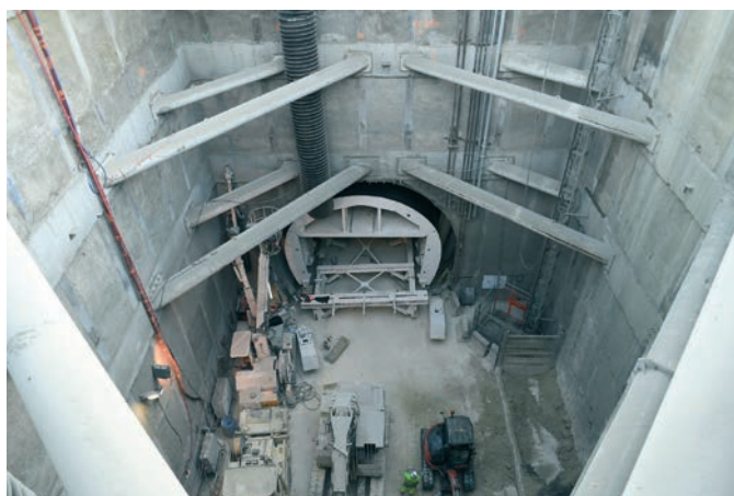
Le puits d'une vingtaine de mètres de profondeur, situé au carrefour de la rue Jean-Marín-Naudin et de l'avenue Stalingrad, accueillera un poste de transformation électrique. On peut voir également l'amorce d'un tunnel allant vers la station terminus Bagneux.
