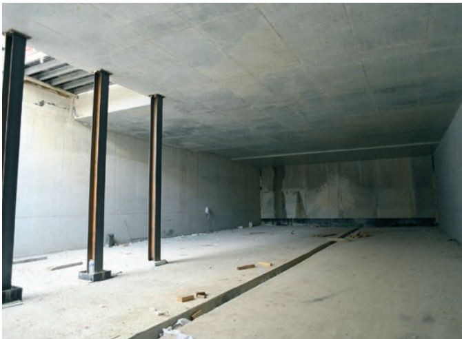
Les tunnels sont creusés par tronçons de 100 mètres de long environ. Ici on peut voir l'intérieur d'un des tronçons de l'arrière gare.
