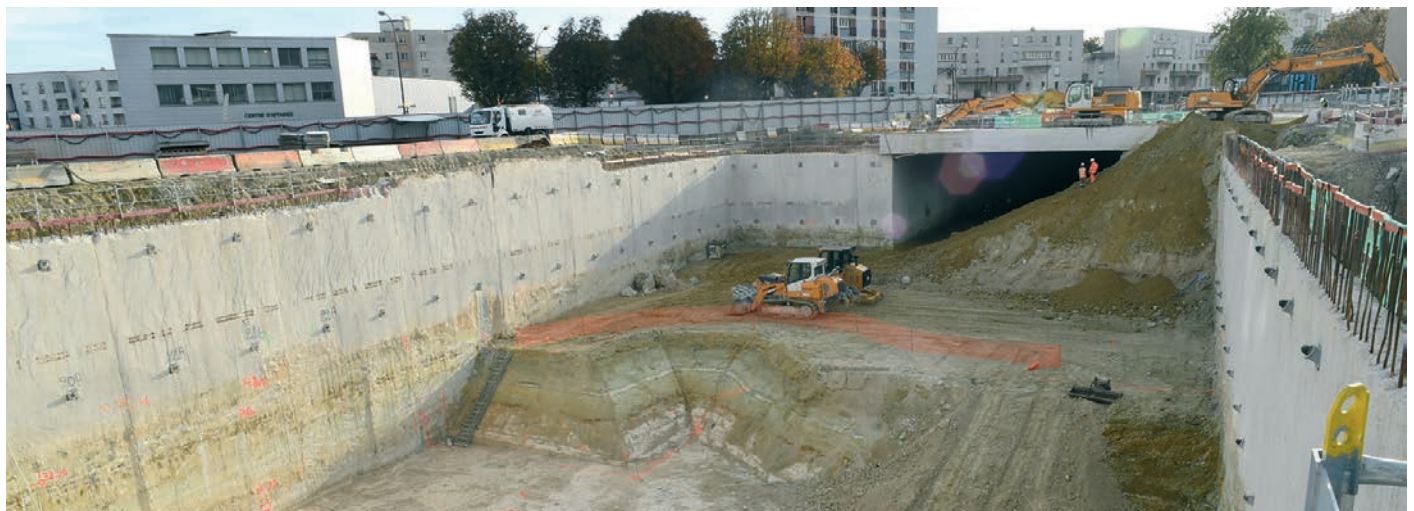
Dans cette tranchée, prendra place la future station Bagneux. On peut voir, sur la partie la plus haute, l'emplacement du futur accès principal de la station. En bas de la pente, la correspondance qui sera créée pour rejoindre la ligne 15.
