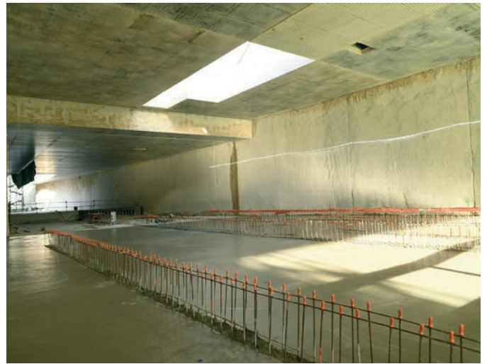
Entrée de la future station terminus Bagneux de la ligne 4, qui comportera deux quais et trois voies.
