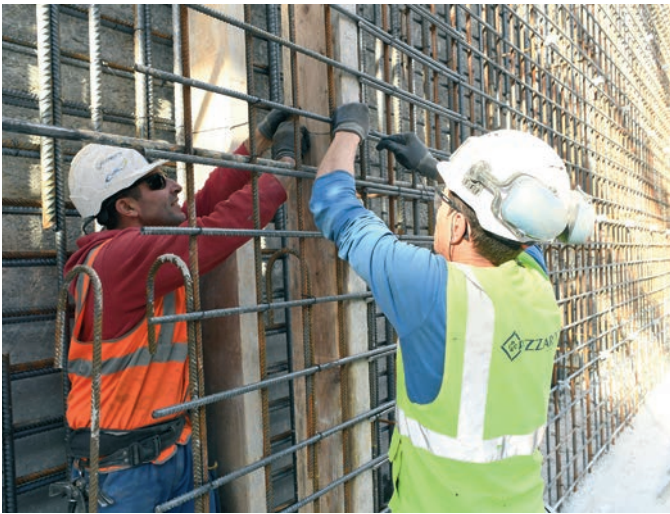
Les ouvriers placent un collier de serrage là où les barres de fer verticales et horizontales se croisent, afin d'assurer leur stabilité.
