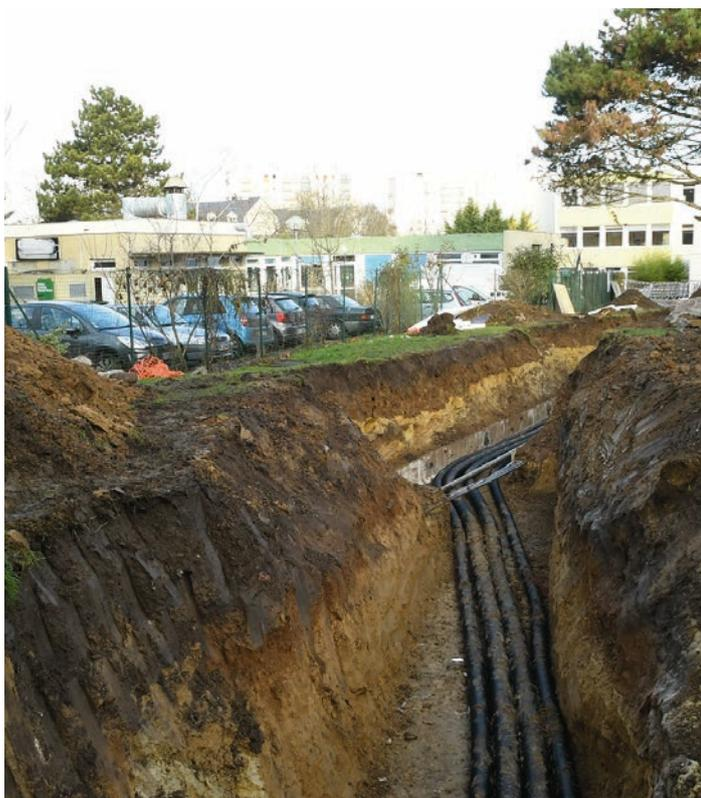
Suite à un problème de fuite sur le réseau de chauffage enterré de l'école Maurice-Thorez en décembre, la Ville a procédé durant les vacances de Noël au remplacement de plusieurs tuyaux et installé des vannes de barrage sur les différents bâtiments. Une deuxième série de tuyaux doit être changée pendant les vacances de février, ce qui permettra ensuite de reboucher la tranchée. L'ensemble de ces travaux représente un coût de 200 000 euros.
