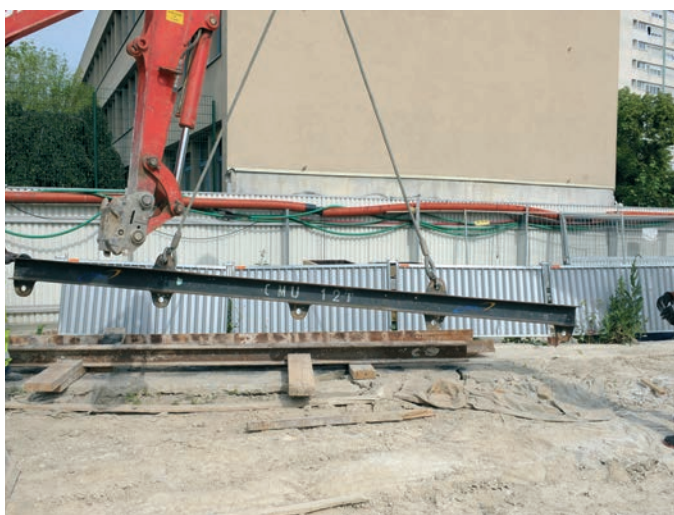
Et là au déchargement de poutrelles métalliques, qui sont stockées en surface avant d'être descendues par une grue dans la tranchée.
