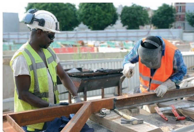
En attendant la prochaine demande de béton, Amadou Ba donne un coup de main sur les différents postes du chantier. Ici il aide à la construction d'une passerelle de sécurité.
