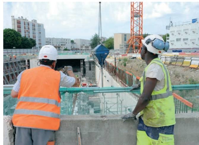
Remplie de sa cargaison, la benne est descendue par une grue dans la tranchée, où les ouvriers récupèrent le béton pour construire les cloisons de la future station.
