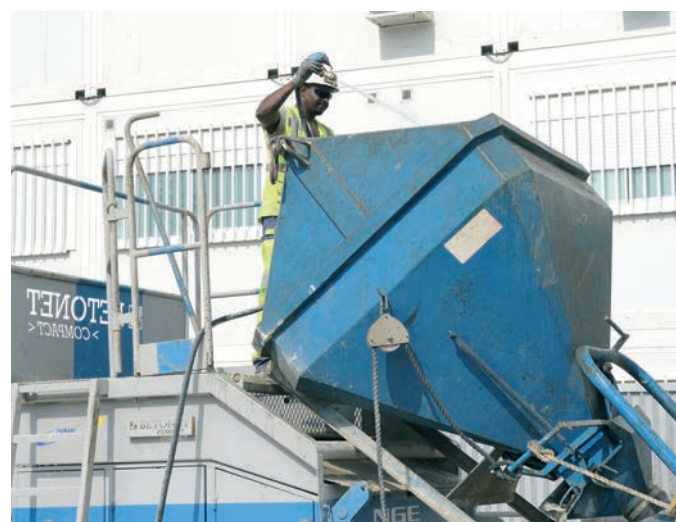
La benne est consciencieusement nettoyée une fois son utilisation terminée et préparée pour une prochaine utilisation.
