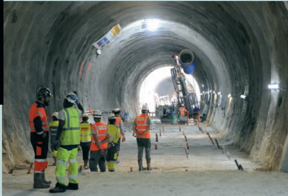
Un Balnéolais sur le chantier du métro P 22
