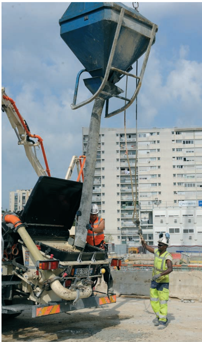
La benne est ensuite débarrassée des résidus de béton pouvant rester au fond.
