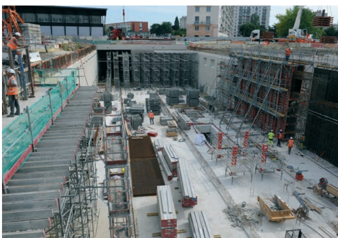
Amadou travaille depuis plusieurs mois sur le chantier de construction de la future station terminus de la ligne 4, au rond-point des Martyrs de Châteaubriant.
