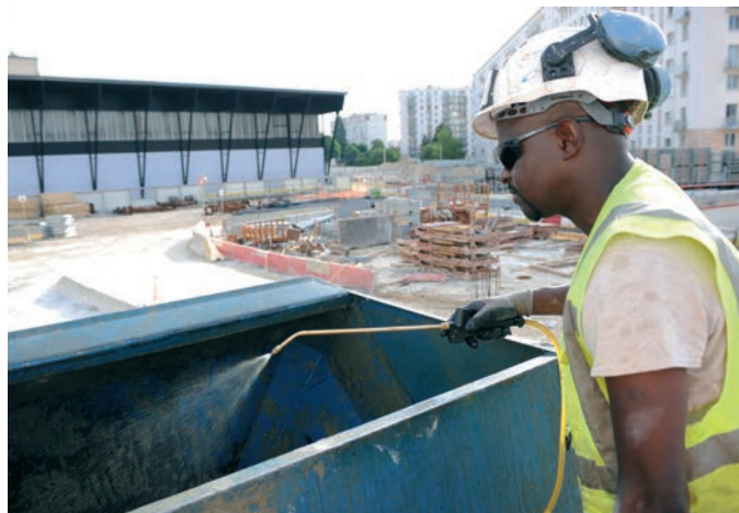
Responsable de la benne d'approvisionnement en béton, Amadou la vaporise d'huile tous les matins pour éviter que le béton ne colle sur les parois.
