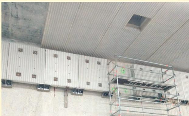
Les travaux se poursuivent sur le futur terminus de la ligne 4 avec la pose d'un revêtement sur les murs et plafonds de la station Bagneux. Un parement en béton ondulé, préfabriqué dans une usine d'Île-de-France, est acheminé sur le chantier pour être installé dans les futurs espaces voyageurs. Au final c'est une surface de 3 000 m<sup>2</sup> de ce matériau qui viendra recouvrir l'intérieur de la station.
