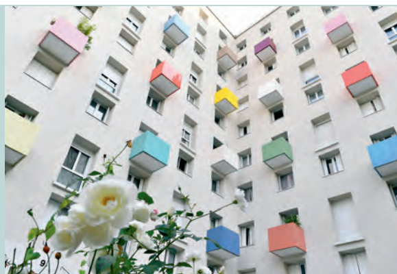
Réhabilitation des logements sociaux P 12
