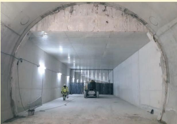
**Méthode conventionnelle** (tunnel voûté) : on creuse le terrain en souterrain, et on évacue les déblais à travers un puits. On positionne au fur et à mesure un soutènement provisoire (structures métalliques et béton fibré) pour maintenir les terres. Enfin on construit l'ouvrage définitif en béton.
