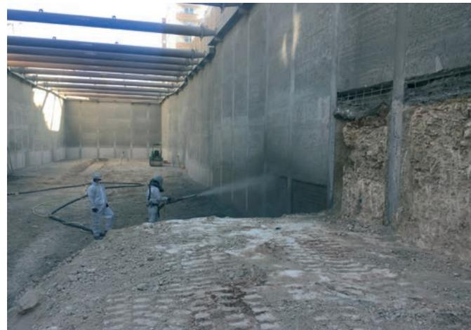
Une fois l'armature posée, le sol et les murs sont couverts d'un béton fibré. "Le coffrage définitif permet une répartition idéale des pressions, à l'image d'un œuf", précise Georges Paolini.
