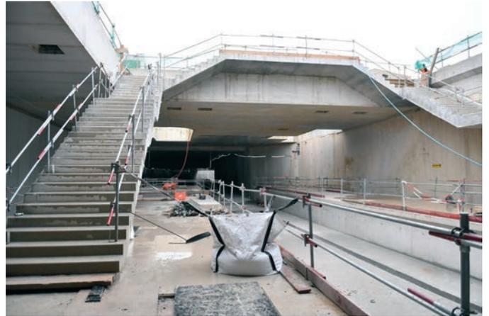
Deux escaliers permettent d'accéder à la station. L'installation d'escaliers mécaniques et d'ascenseurs est également prévue. Ici, les travaux avancent plus vite grâce au creusement à ciel ouvert (lire p.31).
