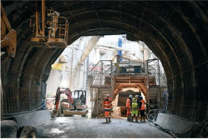
Mise en place de l'outil coffrant à l'accès principal "Verdun Sud". Il reste encore 5 mètres de creusement pour relier la station au tunnel se dirigeant vers la station "Bagneux".
