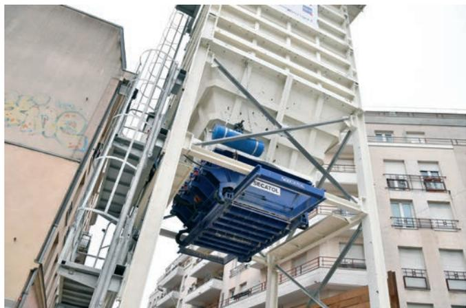
Première étape : l'accès principal de la future station "Verdun Sud". À l'entrée de Montrouge, la trémie réceptionne les tonnes de gravats extraites du sous-sol. Les déblais sont ensuite recyclés pour combler des carrières.
