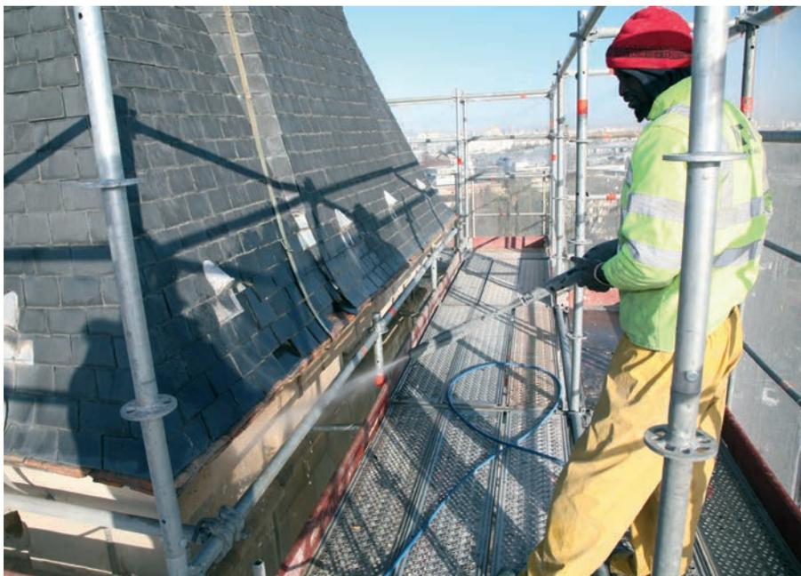
de l'Oise. Restent les joints. En effet, la dernière restauration en 1946 "se préoccupait peu de l'esthétique". Les pierres ont été scellées avec du ciment. Moins cher, le matériau est aussi plus sensible aux intempéries. Des joints en chaux liquide le remplaceront. La remise à neuf du clocher doit s'achever courant juillet.
