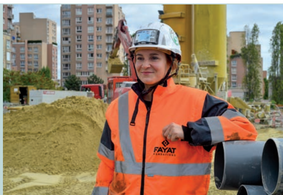
Clémence Dano : elle creuse les fondations de l'école-parc 9
