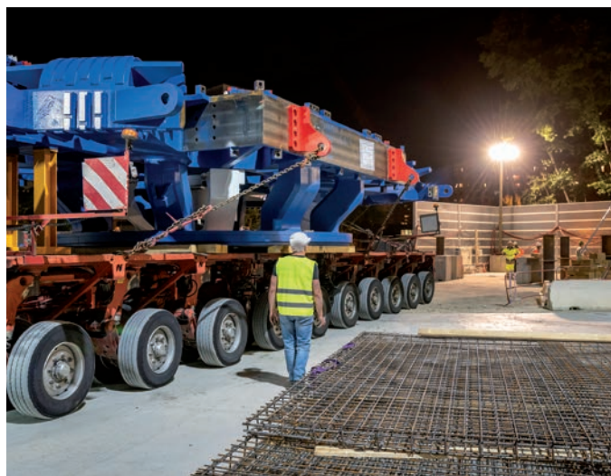
Lourds et volumineux, les morceaux de la roue de coupe sont déchargés au moyen d'une grue installée au plus près du puits de départ du tunnelier.
