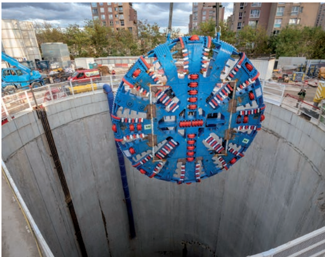
Enfin assemblée, la star circulaire bleue, blanche et rouge du tunnelier amorce, un matin de novembre, sa descente tout en douceur vers le fonds du puits.
