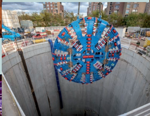
Le tunnelier de la SGP prêt à creuser P 22
