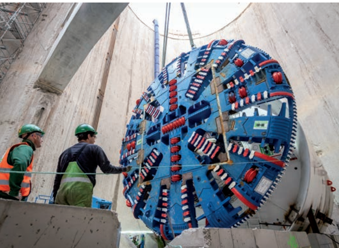
Le tunnelier qui part de Bagneux est le troisième à entrer en action sur le réseau du Grand Paris Express et le premier dans le département des Hauts-de-Seine.
