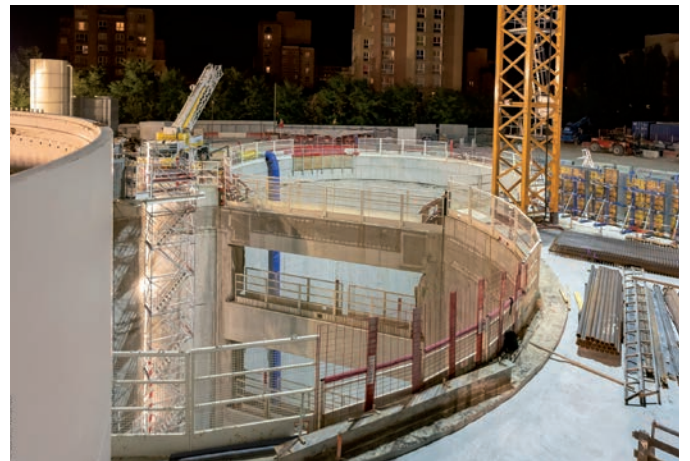
Le puits de départ du tunnelier sera, à terme, un ouvrage de service qui assurera la ventilation et l'accès des secours. Le parc Robespierre sera alors entièrement repaysagé par la Société du Grand Paris, devant la future école-parc Niki-de-Saint-Phalle.
