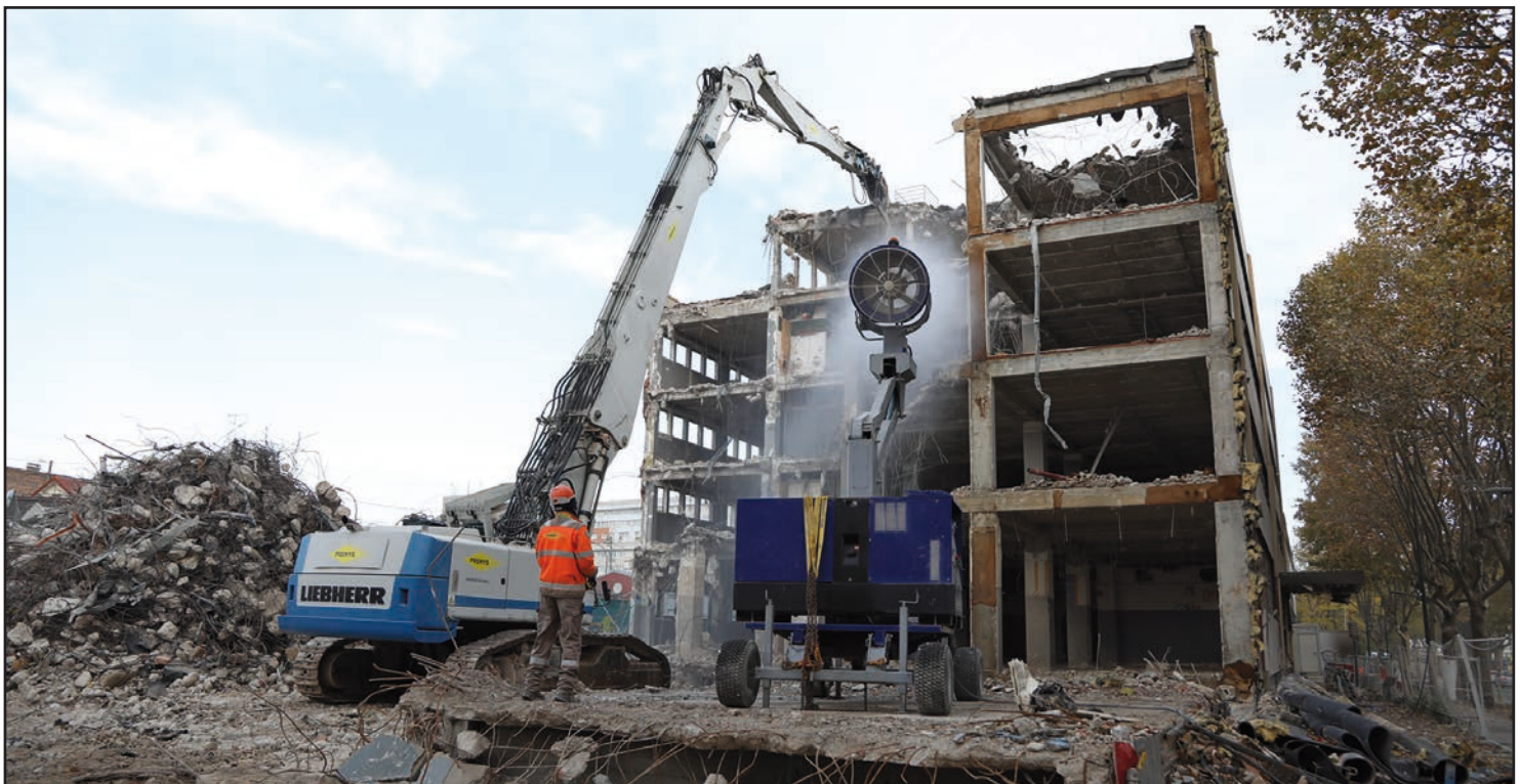
● Construite dans les années 1970, l'extension du bâtiment autrefois occupé par le Reader's Digest aux 5 et 7 avenue Louis-Pasteur, a été démolie en novembre. Cette parcelle fait l'objet d'un projet de construction par le promoteur Ibana d'environ 110 logements neufs, dont les premières livraisons sont attendues fin 2022.
