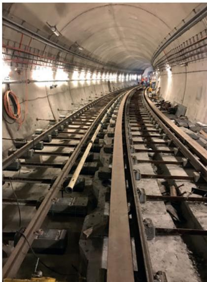
Depuis fin 2020, le tunnel du prolongement de la ligne 4 est raccordé à la ligne existante. Le béton du radier (bas du tunnel) a été coulé et tous les éléments de voies sont posés. Ainsi, ce sont maintenant les trains de chantier qui peuvent passer d'une zone à l'autre pour faciliter les travaux du prolongement. Bientôt, grâce à l'électrification de ce raccordement, des trains sans voyageurs pourront même accéder au nouveau centre de dépannage, lors de sa mise en service.
