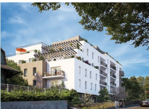
51 futurs logements rue des frères Lumière P 31
