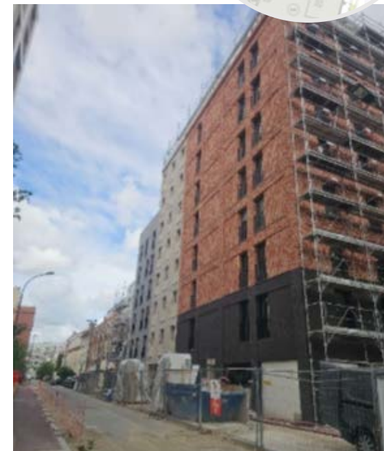
Façade donnant sur l'avenue Aristide-Briand
