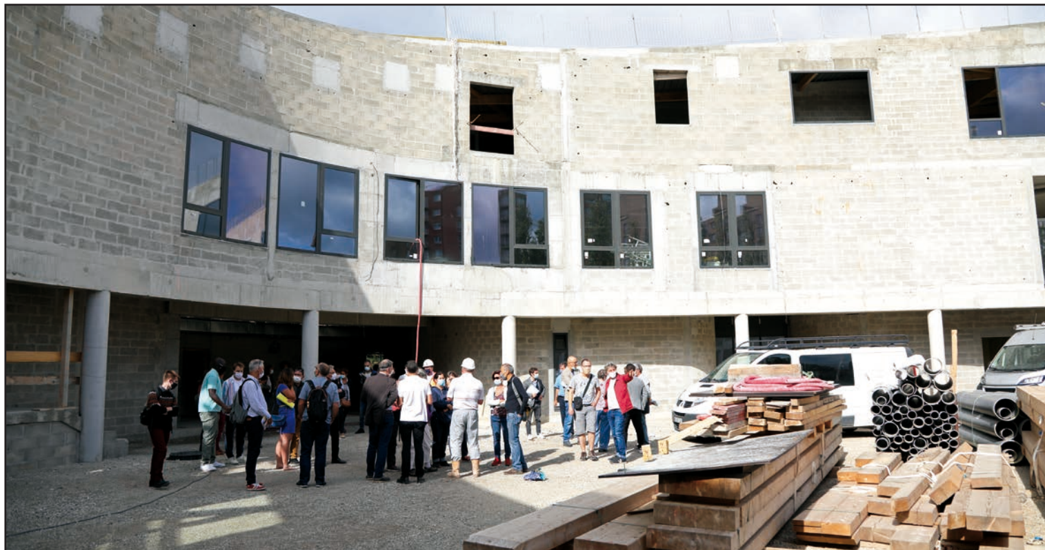
Comme chaque année les élus et les services municipaux ont visité les chantiers de la ville, le 26 août, comme ici celui de la future école Niki-de-Saint-Phalle, qui ouvrira ses portes dans le quartier nord en septembre 2021.
