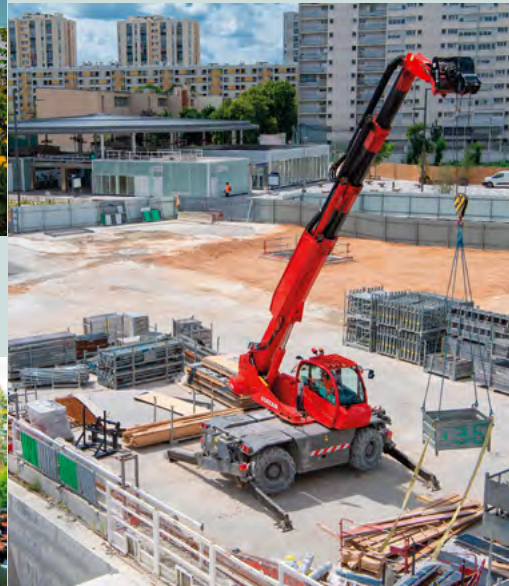
À la découverte du chantier de la ligne 15 P22
